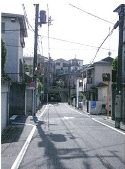
坂の多い西大井地区の道路予定地。正面には10mの丘があり、それを切り開いて道路を通すこととなります。
